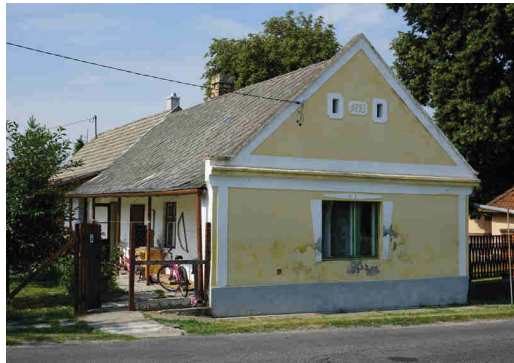
Dózsa Gy. u. 36. (hrsz. 442), védendő érték: oromzat, tornác
