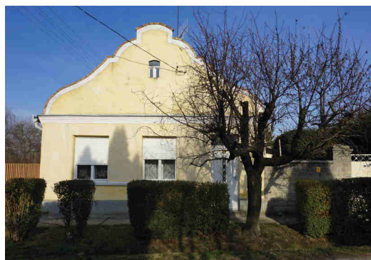
Rákóczi u. 21. (hrsz. 152), védendő érték: oromzat, tornác
